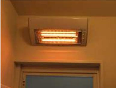
脱衣室に壁付けヒーターを取り付けました。脱衣室は手を伸ばしたり、洗濯物を干すので邪魔にならないドア上の高い所に設置しました。遠赤外線暖房でポカポカ(\*^-^\*) 人感センサー付で消し忘れの心配がないんですよ。冬場のヒートショック防止にも役立ちますね。玄関やトイレにも設置できます。1台2役。夏は扇風機にもなり便利です。
